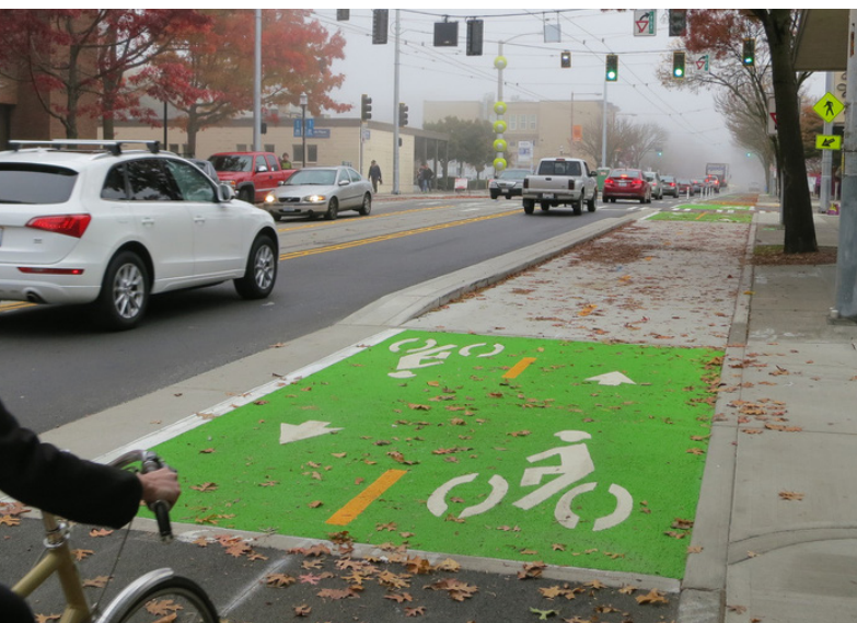
Concrete Curb Borde de Concreto
